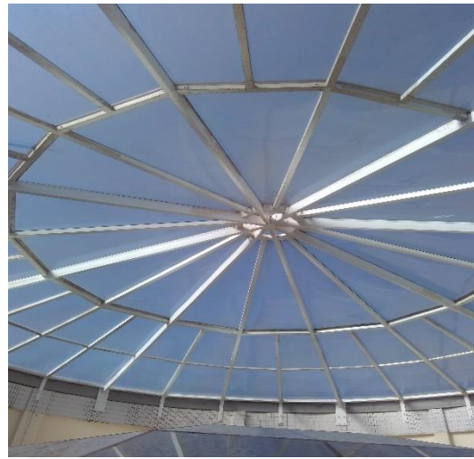
Foto 17 – Detalhe da cobertura metálica e vidro da cúpula
