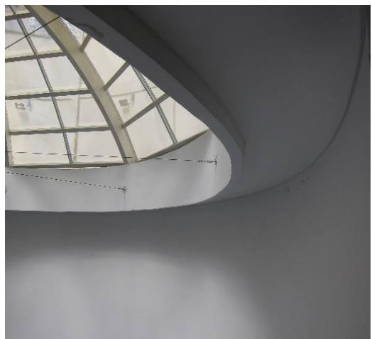
Foto 11 – Detalhe do cabo de aço ancorado na viga
